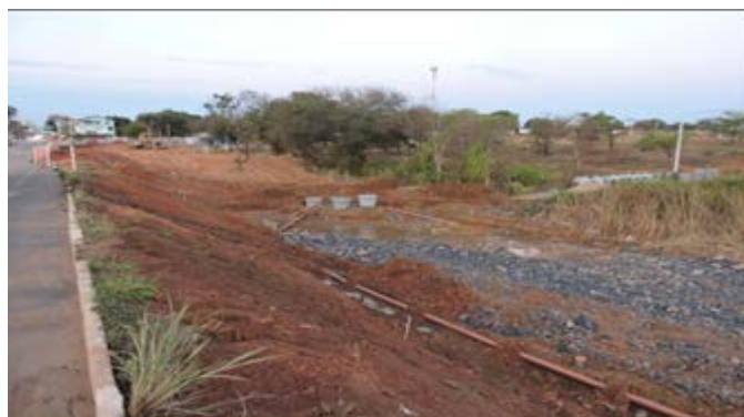
Figura 3 - Base da obra de drenagem do loteamento ao longo da Avenida Francisco Gaetani, reforçada com “fundo de pedreira”.
